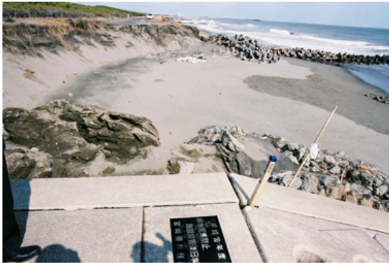
護岸と自然海岸の切れ目の汀線後退(宮崎県)
