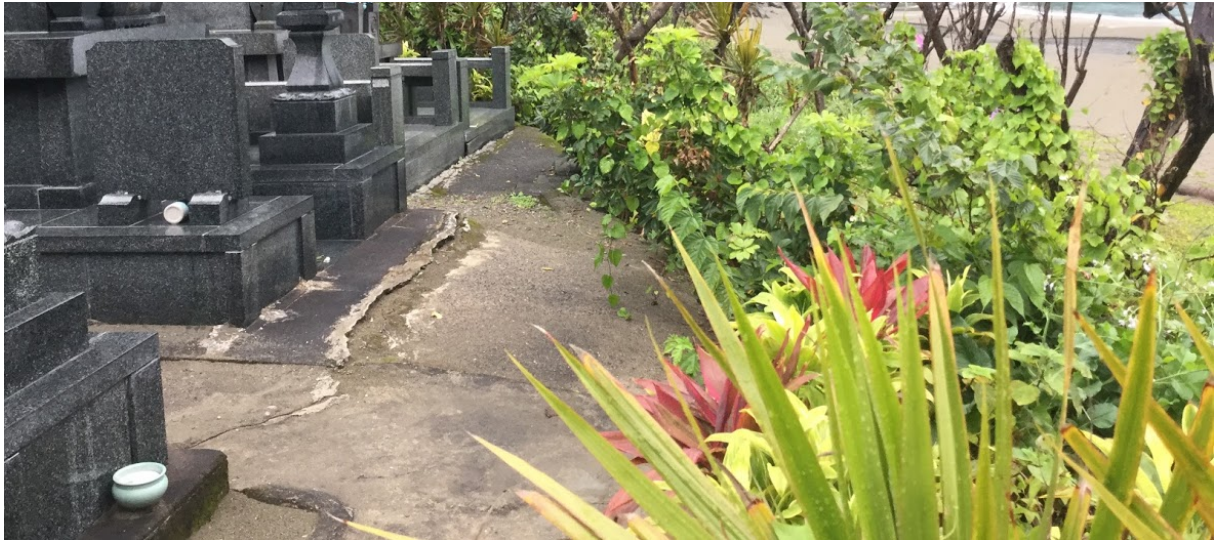
図 4-3-5 海側の通路の状態（ひび割れ状況）
