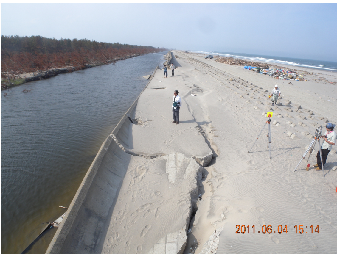
図 4-4-3 津波による砂移動の阻害事例（宮城県）
