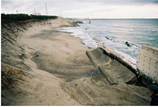
護岸隣接部の背後砂丘の崩壊(茨城県阿字ヶ浦)
