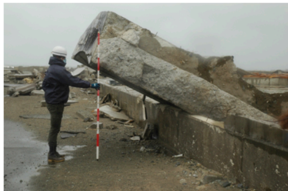
宅地に侵入した護岸(宮城県)
