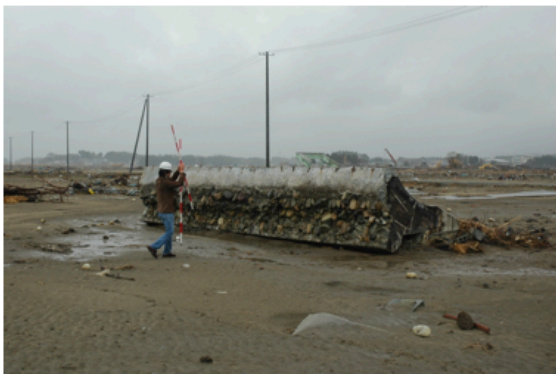
倒壊した護岸は 400m 以上内陸まで移動(宮城県)
