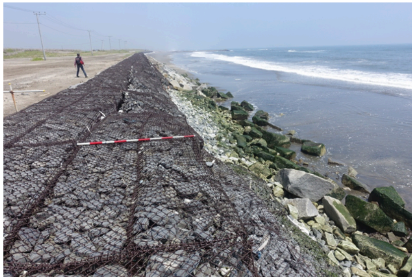
護岸を前出しして建設すると完成は永久にない。毎年壊れる（九十九里海岸）
