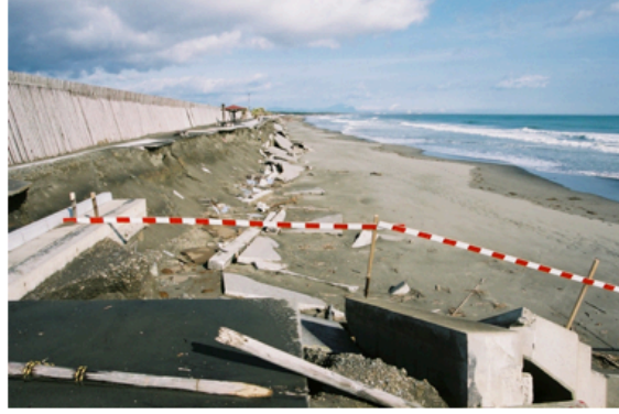
護岸の粉碎の例(宮崎県)
