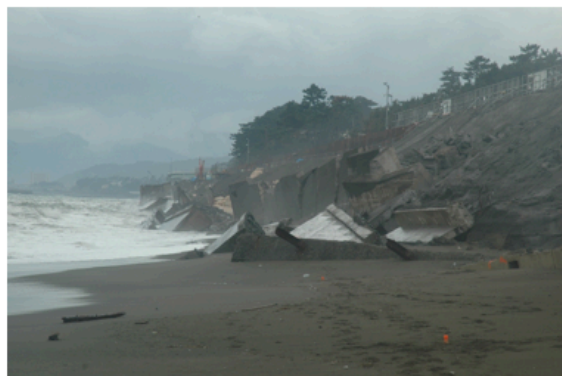
直立護岸の崩落(神奈川県)
